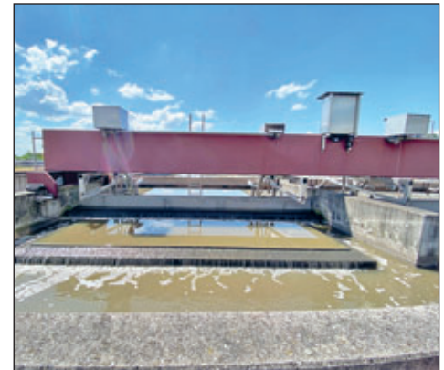
Bild 2: Längsbecken, von denen zwei ständig im Betrieb (Sommer- und Winterbecken) sind (Bild: WAD GmbH)
